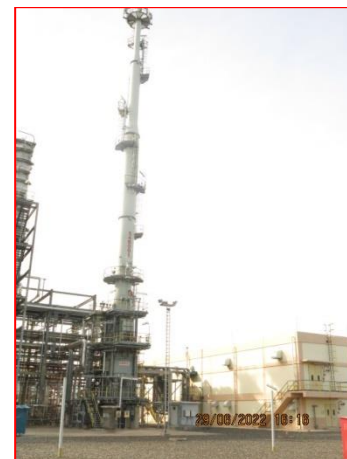
ภาพที่ 2.2-1(6) ปล่อง Hydrodesulfurization Reactor Heater Stack (54B001)
