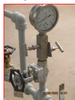
ภาพที่ 2.2-1(68) อุปกรณ์วัดความดัน (Pressure Indicator)
