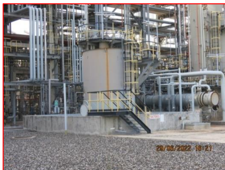
ภาพที่ 2.2-1(65) กำแพงกันโดยรอบ บริเวณที่เก็บสารเคมี
