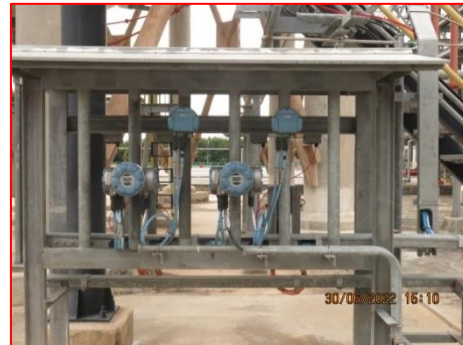
ภาพที่ 2.2-1(70) อุปกรณ์วัดระดับ (Level Indicator)
