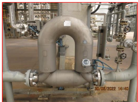
ภาพที่ 2.2-1(79) Flow Meter วัดอัตราการไหลของสารในท่อ
