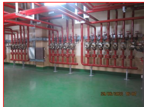
ภาพที่ 2.2-1(48) ระบบดับเพลิงด้วยก๊าซ บริเวณที่เกี่ยวข้องกับอุปกรณ์ทางระบบไฟฟ้า สายไฟ และสถานีไฟฟ้าย่อย
