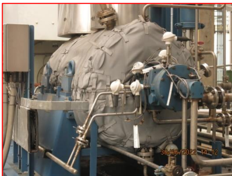
ภาพที่ 2.2-1(34) การติดตั้งฉนวน เพื่อลดเสียงจากอุปกรณ์
