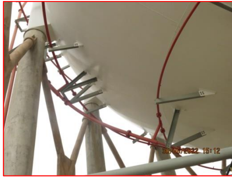
ภาพที่ 2.2-1(45) ระบบสเปรย์น้ำดับเพลิง บริเวณถังเก็บก๊าซปิโตรเลียมเหลว LPG
