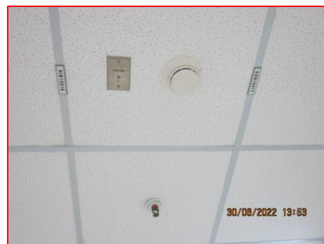
ภาพที่ 2.2-1(54) อุปกรณ์ตรวจจับความร้อน
