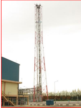
ภาพที่ 2.2-1(12) หอเผาที่ระดับเหนือพื้นดิน (Elevated Flare)
