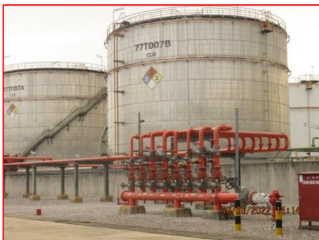
ภาพที่ 2.2-1(47) ระบบฉีดโฟมดับเพลิง บริเวณถังเก็บ Flammable Liquid และ Combustible Liquid
