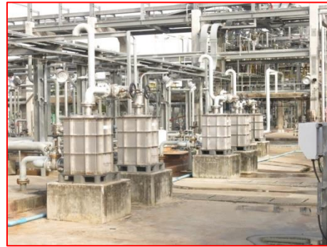
ภาพที่ 2.2-1(15) ตัวดูดซับด้วยถ่าน (Activated Carbon Canister) ที่บริเวณระบบบำบัดน้ำเสีย
