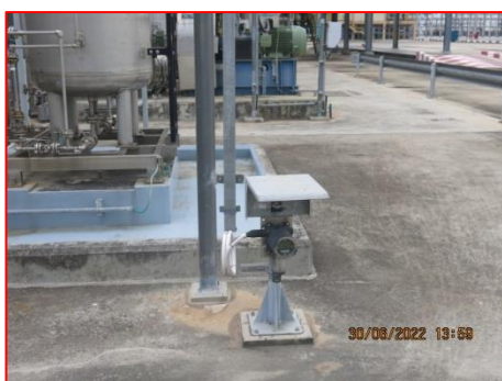
ภาพที่ 2.2-1(55) อุปกรณ์ตรวจจับการรั่วไหลของก๊าซ
