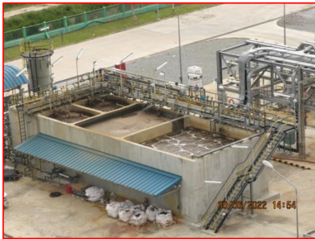
ภาพที่ 2.2-1(24) ระบบบำบัดชีวภาพของหน่วย SCTU
